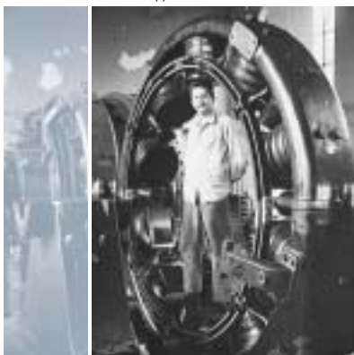
Ein Arbeiter in einem Elektromotor etwa um 1900 (3)
