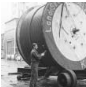
Land- und Seekabelwerke, Abteilung Prüffeld, das Starkstrom-Prüffeld, an der Kabeltrommel der Prüfer Walter, Anfang der 60er Jahre (3)
