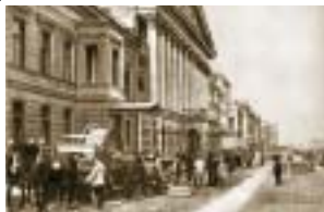
Im russischen St. Petersburg werden um 1898 Kabel der Land- und Seekabelwerke verlegt; diese Kabel wurden erst im Jahre 2001 ersetzt. (4)
